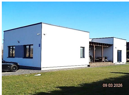
Ēkas fasāde ar terasi
