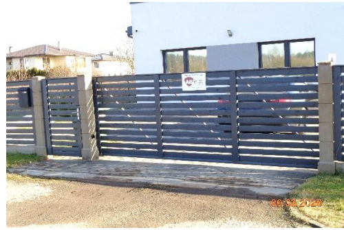
Gājēju vārtiņi un vārti pie iebrauktuves Zemesgabala teritorijā
